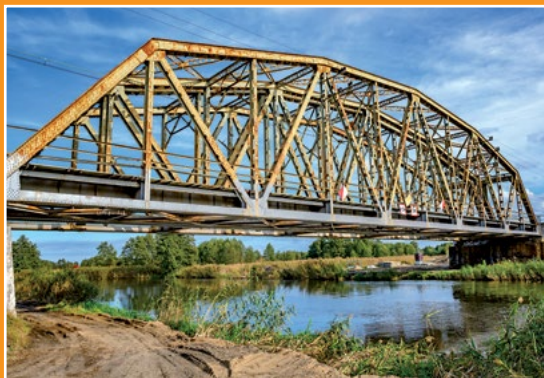
Most kolejowy na Noteci Eisenbahnbrücke auf der Netze
