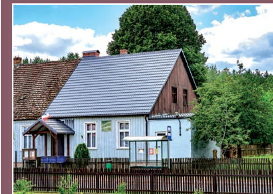
Świetlica wiejska w Kwiejcach Starych Gemeinschaftshaus in Kwiejce Stare
