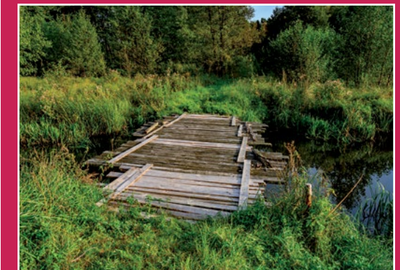
Kładka na szlaku turystycznym w Piłce Steg auf dem Wanderweg in Piłka
