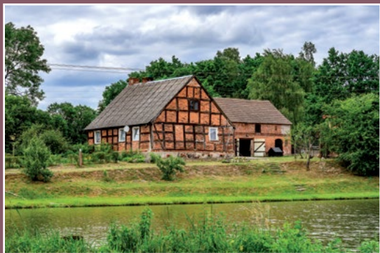
Szachulcowy dom w Dębogórze Fachwerkhaus in Eichberg
