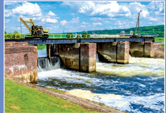
Jaz na Noteci Stauwehr an der Netze
