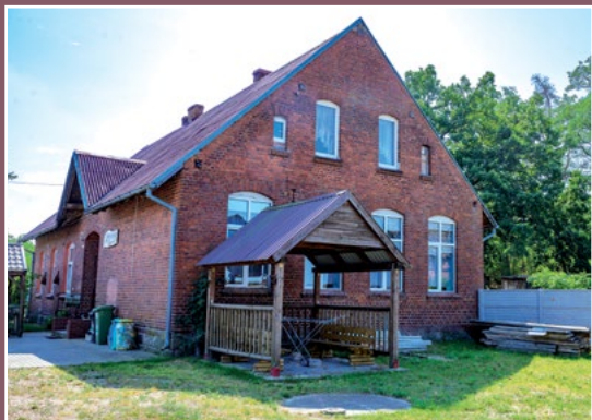
Szkoła w Bukowcu Schule in Buchwerder
