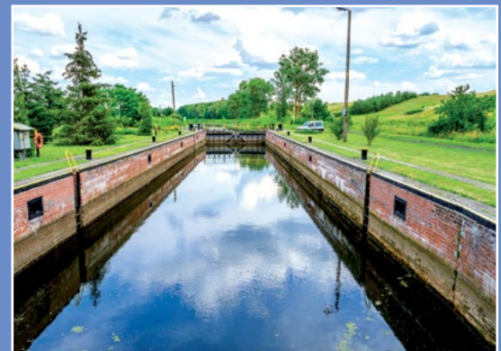
Śluza na Noteci Schleuse an der Netze
