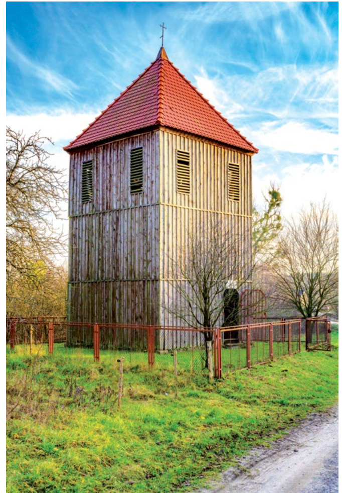
Dzwonnica w Radosiewie Glockenturm in Radosiew
